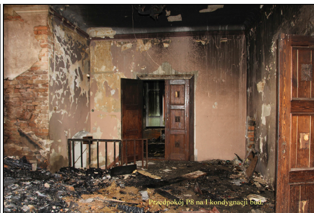
foto.8. Przedpokój P8 na I kondygnacji bud.
