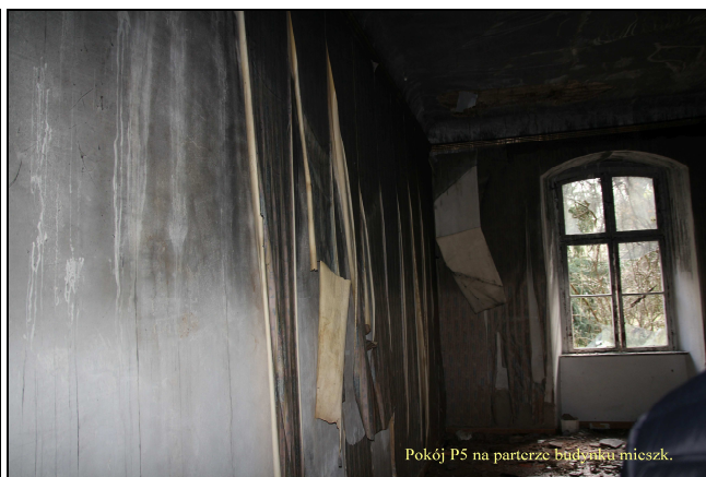
foto.6. Pokój P5 na parterze budynku miesz.
