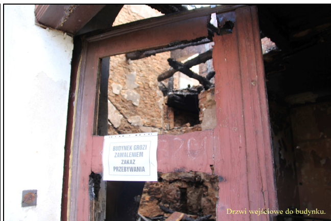
foto.10. Drzwi wejściowe do budynku.
