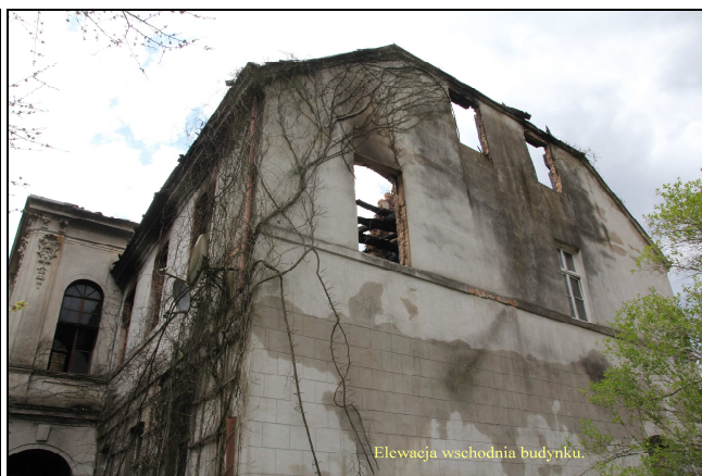
foto.2. Elewacja wschodnia budynku.
