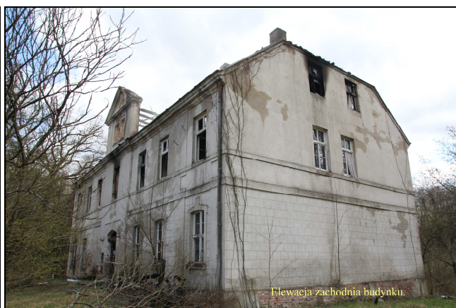
foto.4. Elewacja zachodnia budynku.
