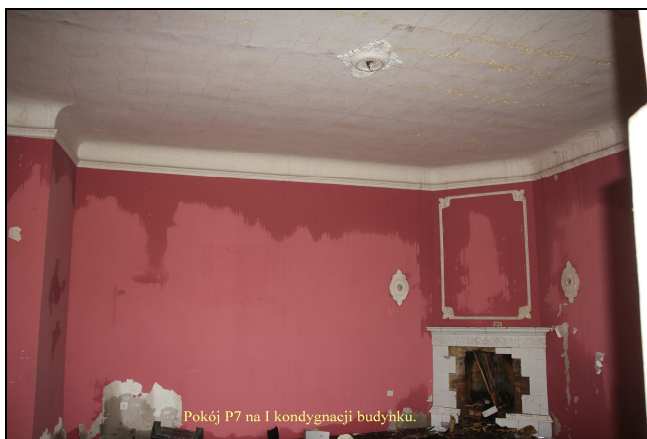
foto.7. Pokój P7 na I kondygnacji budynku.
