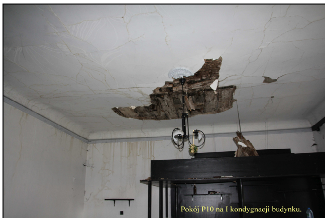
foto.9. Pokój P10 na I kondygnacji budynku.
