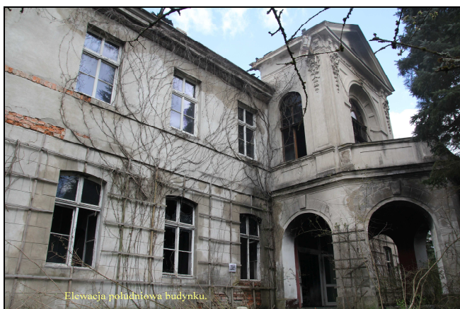
foto.3. Elewacja południowa budynku.
